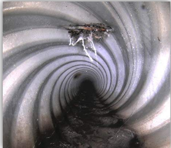
Photo 2 - Pipe Gouge
